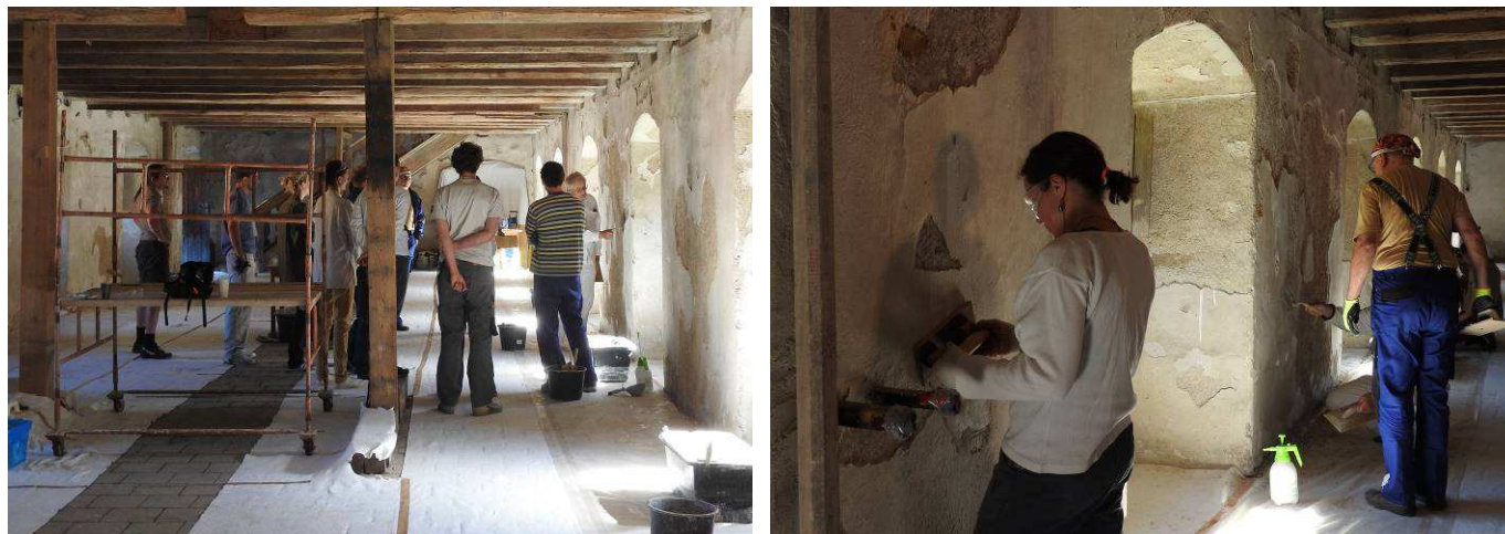
Obr. 3: Interiér sýpky při vstupním vysvětlování postupu zpevňování barokních omítek a doplňování tenké vrstvy mladšího vápenného štku. Cílem zásahu bylo zachránit maximum cenných barokních omítek a doplněním chybějících omítek vrátit prostorům zaniklou podobu. Práce budou pokračovat i v dalších letech. I v sýpce bylo potřeba chránit barokní podlahy a trámy.
