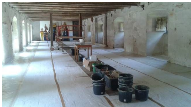
Por. 2. Příprava vápenné vody a vápna pro záchranu a opravu omítek v interiéru.
