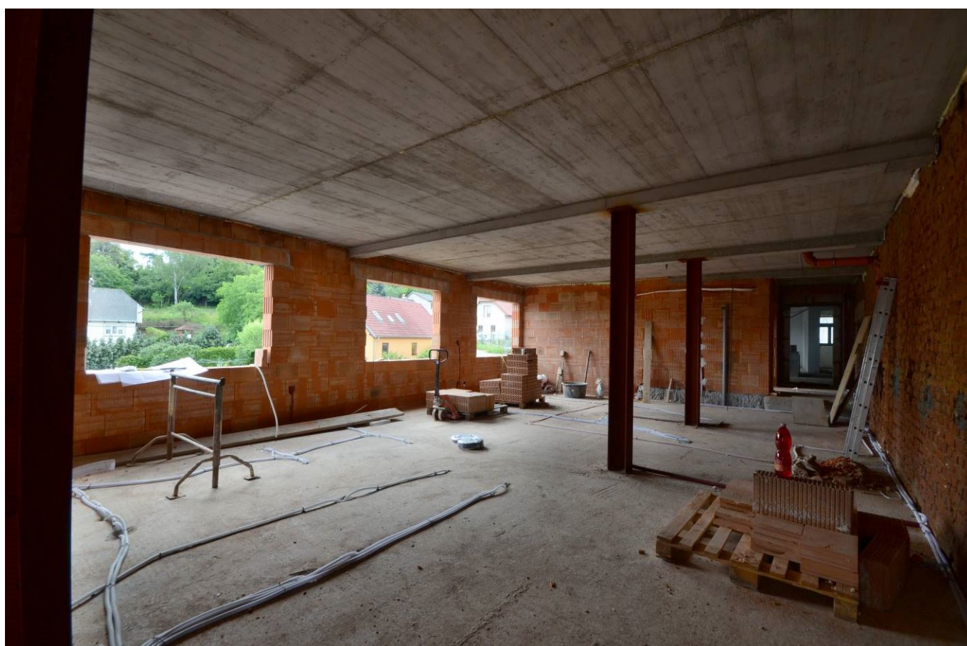
Přístavba stavebního úřadu
